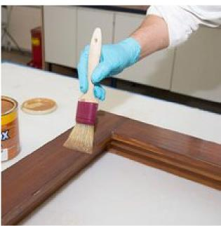
Procedere quindi con tre mani della vernice Dickschichtlasur Pullex Aqua-DSL per far si che la superficie asciutta raggiunga una resistenza di  $80~\mu$  – et voilà, ecco a voi la "nuova" finestra!
