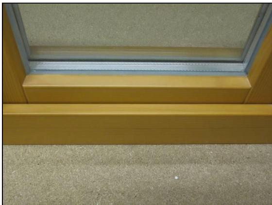
**Fig. 4.3: Finestre senza protezione dalle intemperie**
