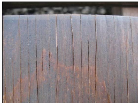
fig. 2.3: Formazione di screpolature
