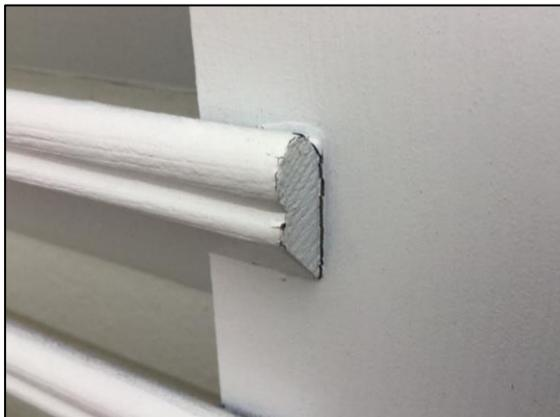
Fig. 4.3: Fessure nella giunzione e sugli spigoli non sufficientemente arrotondati
